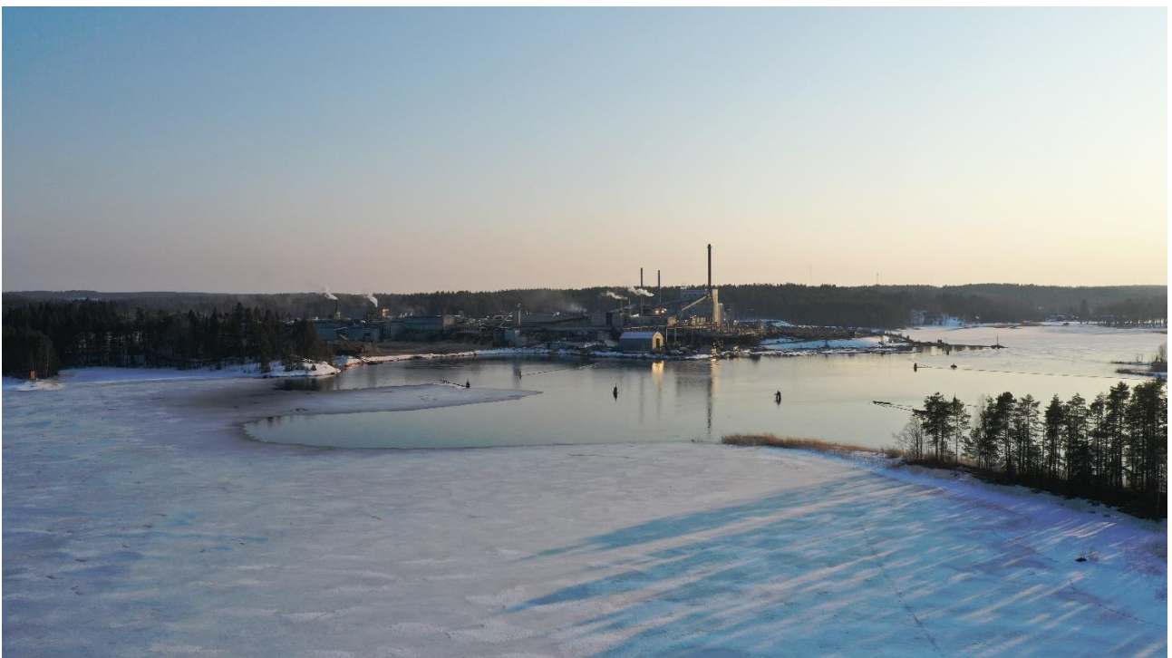
Kuva 43. Tehdasaluetta viistoilmakuvattuna laivaväylältä teollisuusalueen itäpuolelta. (Kuva: Teppo Jukarainen 2022)
