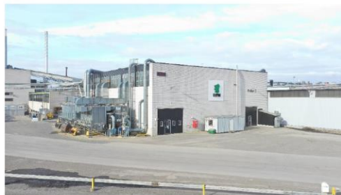
Vanhan ja uuden osan kytkeytyminen (1-16) länsipuoli. Vanhan osan kyljessä näkyy uudistettuja prosessiin liittyviä teknisiä laitteita
