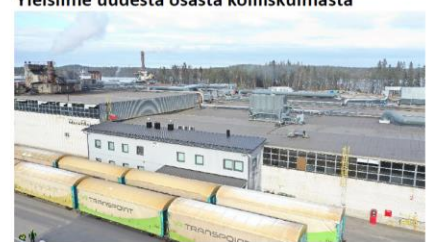
Uuden ja vanhan osan liittymä lounaispuolella
