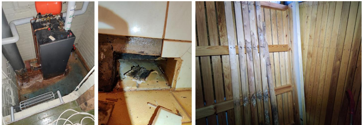
Kuva 44. Työmaakuvia edustussaunan kuntoselvityksen työmaakäynniltä 22.12.2021 (kuva: Teppo Siponkoski, FCG 2021)
