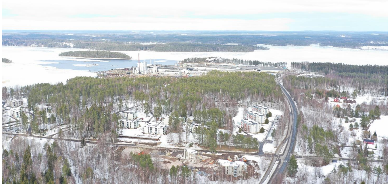
Kuva 40. Teollisuusalueen ja olemassa olevan rakenteen vaihtumisvyöhyke. (Kuva: Teppo Jukarainen 2022)
