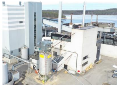
5. Vanha voimalaitos (matala osa) kytkettynä uuteen voimalaitokseen
